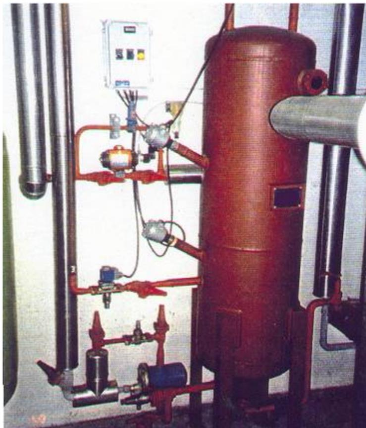
Figura 3.9 – Exemplo de um regenerador de R-717 com vapor quente automatizado
