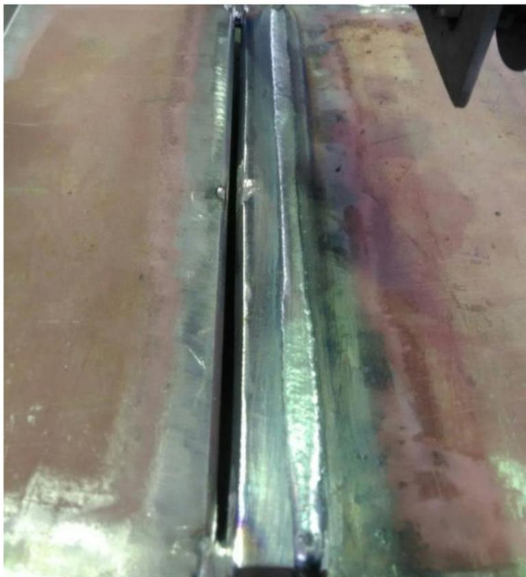
Figura 18: Variação da abertura de raiz da segunda junta.
