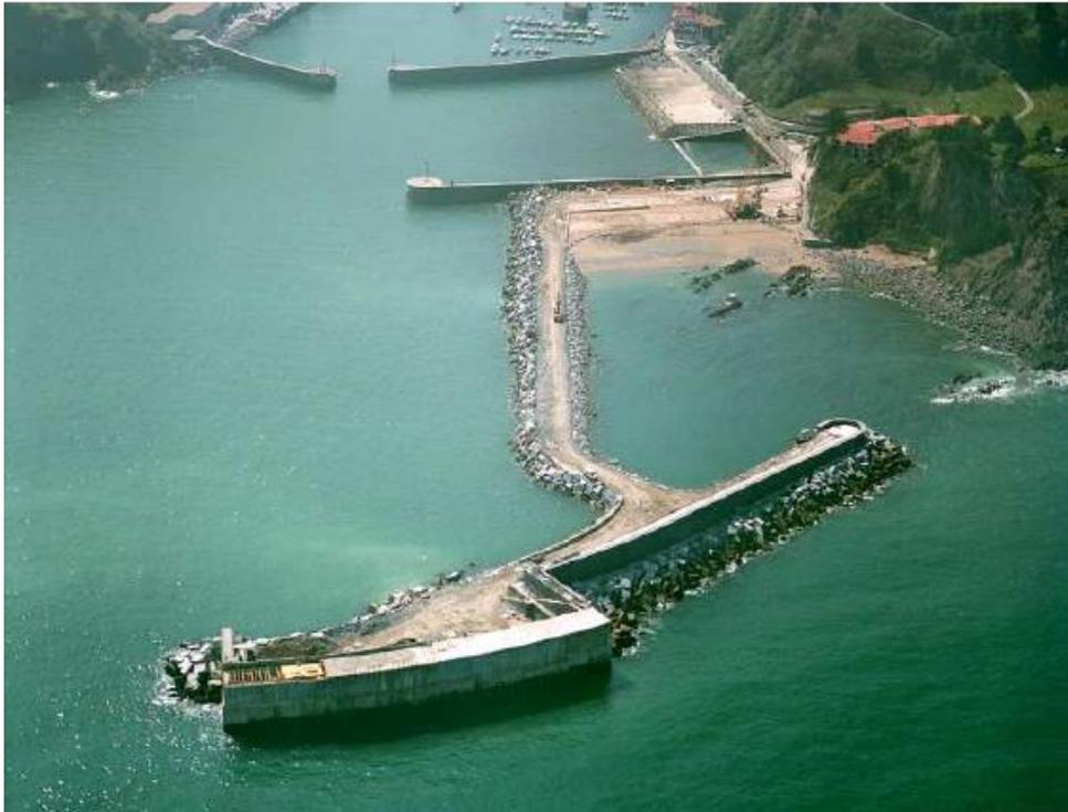
Figura 1.2 – Quebra-mar de Mutriku com dispositivos CAO acoplados
