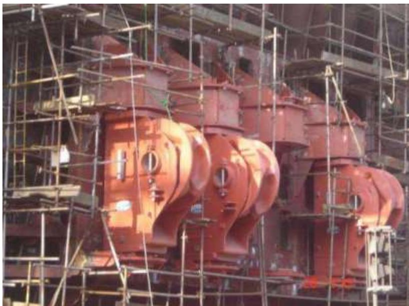
Figura 1.3. Andaimes para montagem dos *brackets* e dos *fairleads* na plataforma FPSO Vitória.
