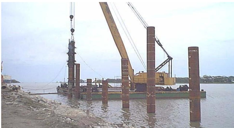
Figura 3.7 – Cravação de tubo metálico (Lobo, 2003).
