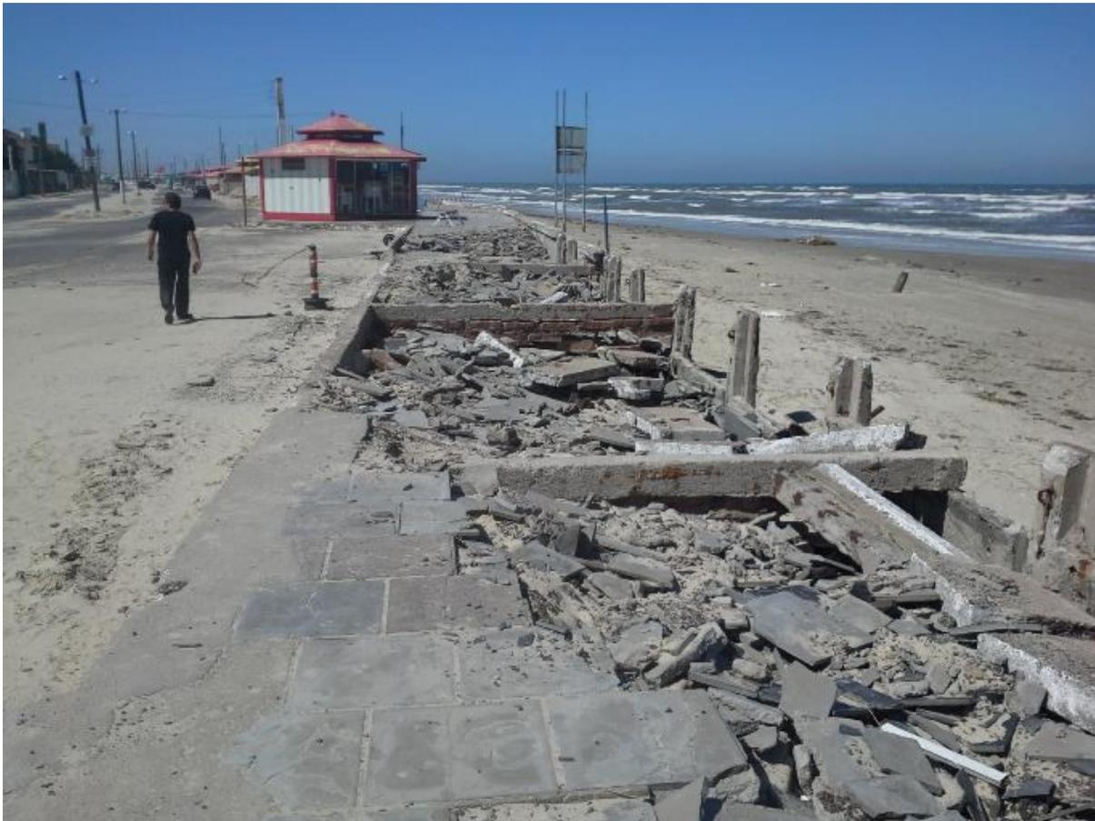
Figura 43. Calçadão e mureta de contenção parcialmente destruídos em Balneário Imbé.
