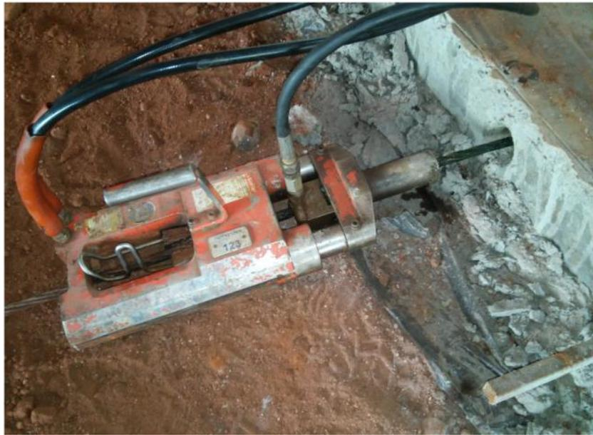
Figura 2.16: Macaco hidráulico sendo posicionado para começar a protensão
