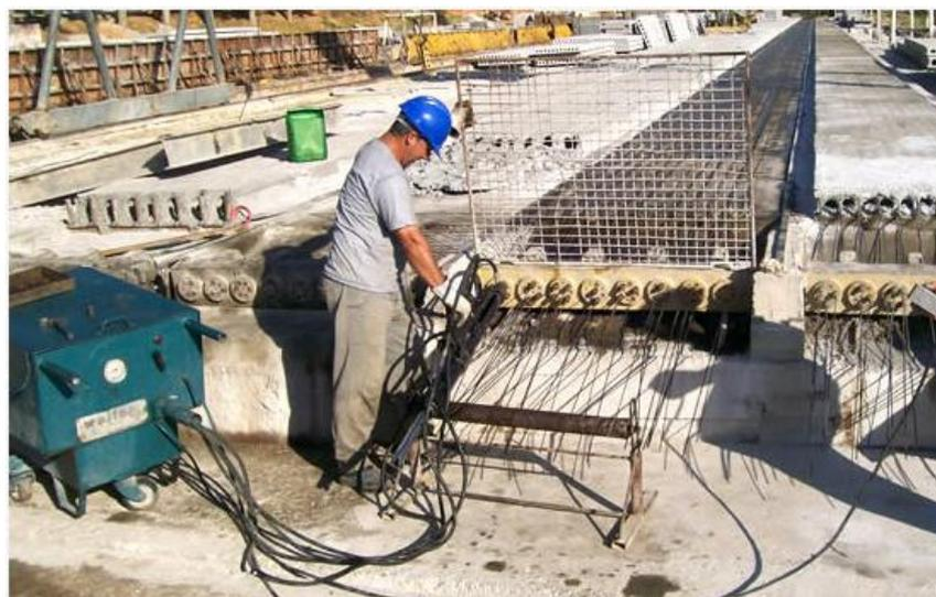
Figura 2.3: Execução de laje alveolar em concreto protendido
