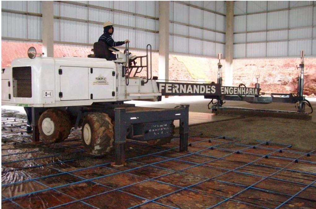
Figura 2.13: Adensamento e nivelamento do concreto por meio de plataforma *laser screed*
