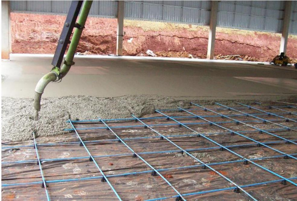
Figura 2.12: Lança do caminhão bomba espalhando o concreto
