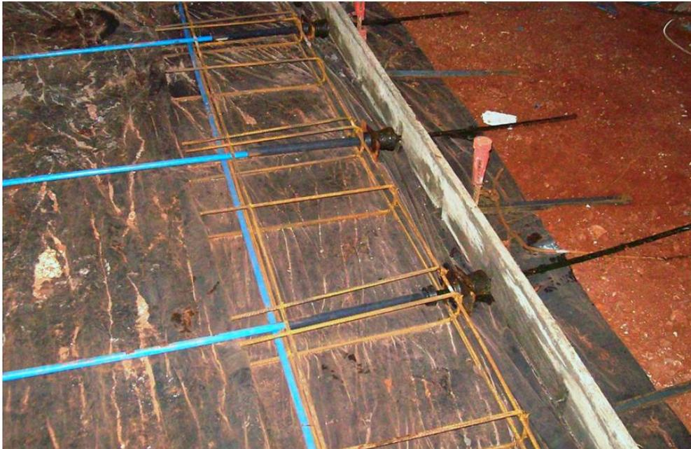
Figura 2.11: Armadura de reforço de borda e fretagem
