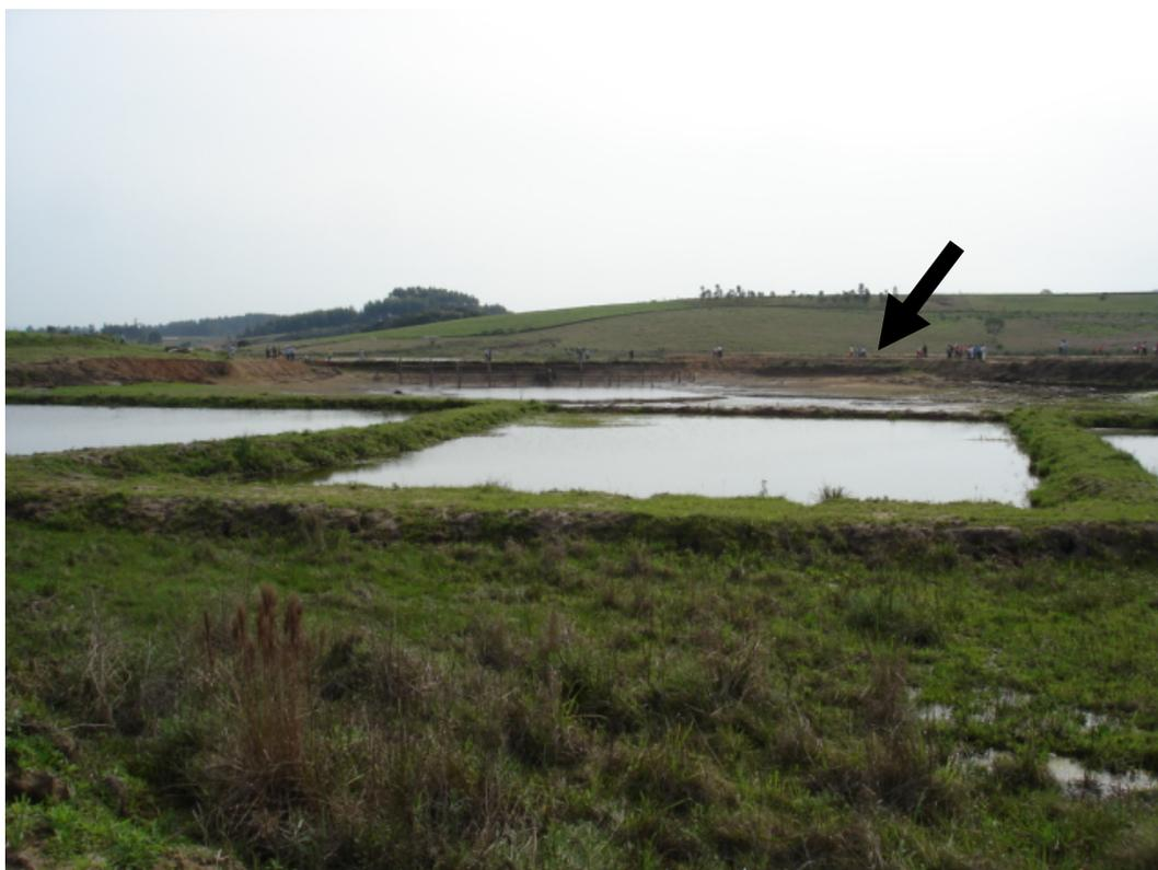
Figura II-3. Tanque de piscicultura vazio devido a rompimento de talude.
