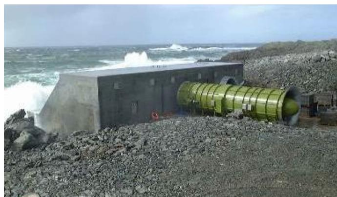
Figura 2.9 Projeto da câmara *OWC* do Limpet (Wavegen, 2011) .
