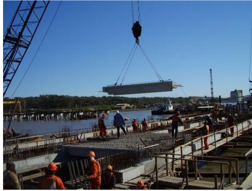
Figura 1.8 – Vigas pré-moldadas protendidas tipo PI – Montagem da estrutura (TECON-RG).
