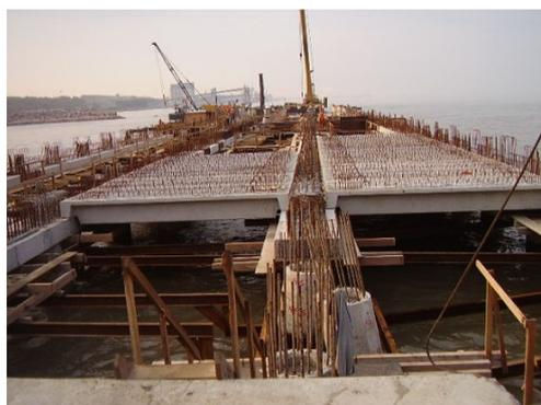
Figura 1.7 – Vigas pré-moldadas protendidas tipo PI – Montagem da estrutura (TECON-RG).
