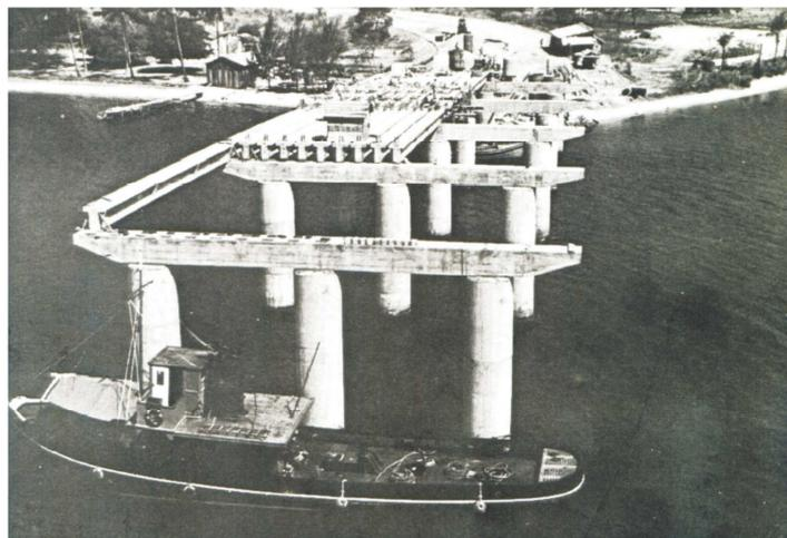
Figura 1.11 – Construção da Ponte do Galeão (Vasconcelos, A. C. - O Concreto no Brasil).
