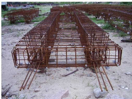
Figura 1.5 – Vigas pré-moldadas protendidas tipo PI – Armadura passiva (TECON-RG).
