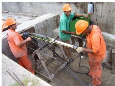
Figura 1.2 – Estacas pré-moldadas protendidas – Protensão das cordoalhas (TECON-RG).
