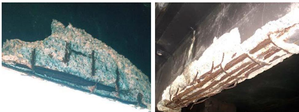
Figura 1.2 – Processo de deterioração de armaduras no ambiente marítimo.
