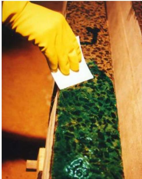
Figura 2.4 – Aplicação da resina epóxi.
