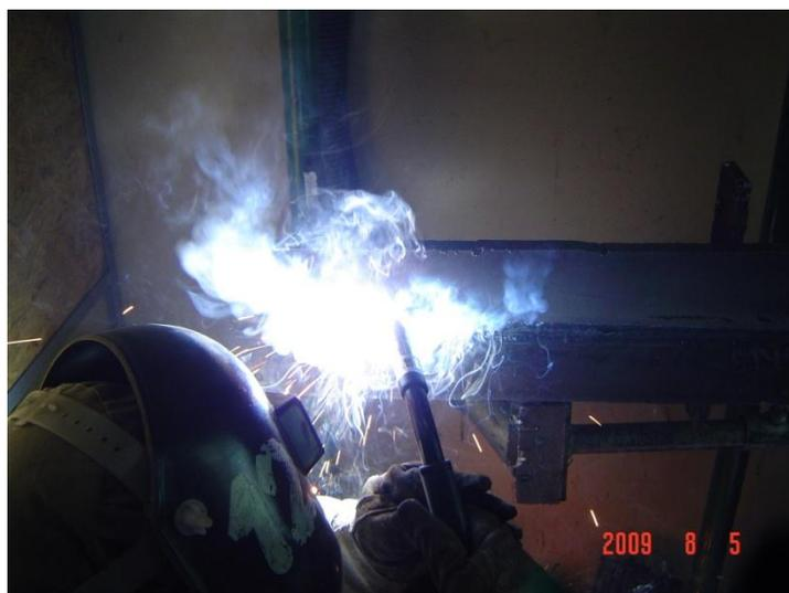
**Figura 1** – Processo de soldagem a arco elétrico.
