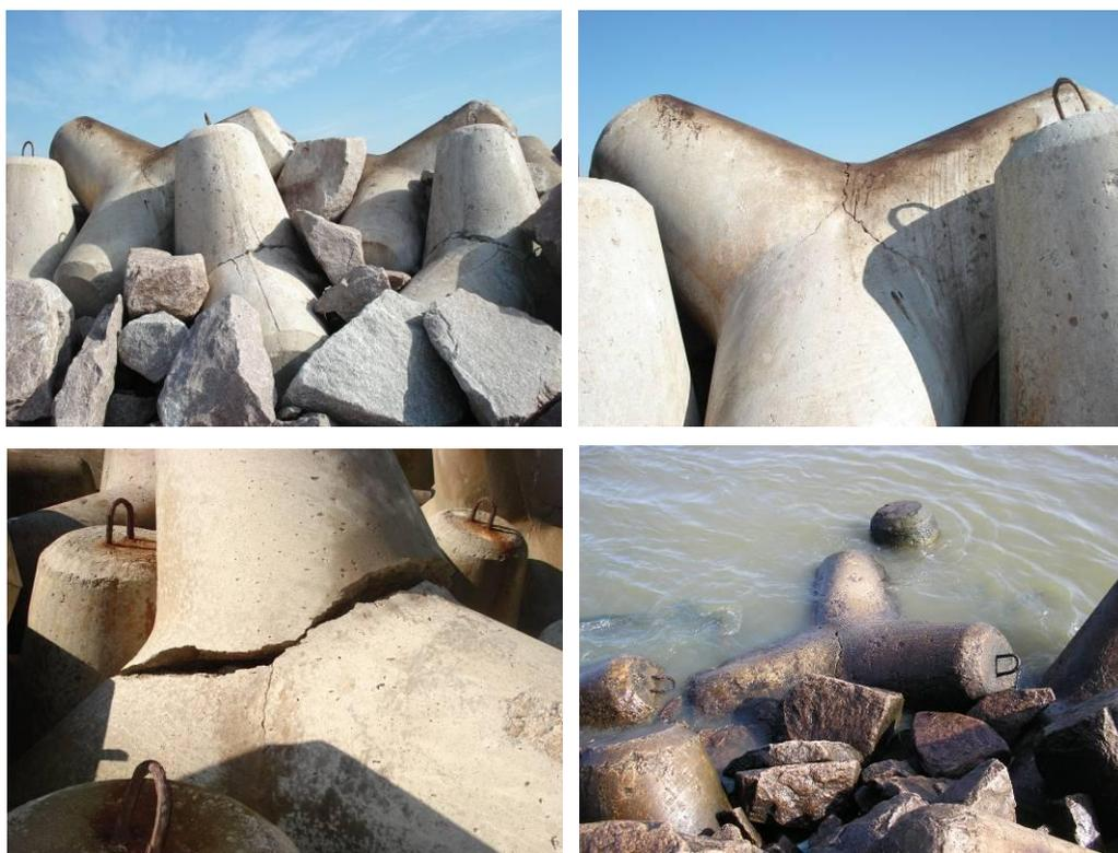
Fig. 2.22 – Fraturamento encontrado na junção das “pernas” (MIGLIORINI, 2007).
