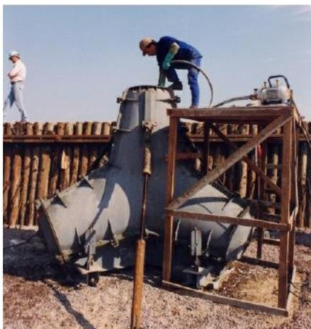
Fig. 2.12 – Vibração durante a concretagem (RIMA, 1999).
