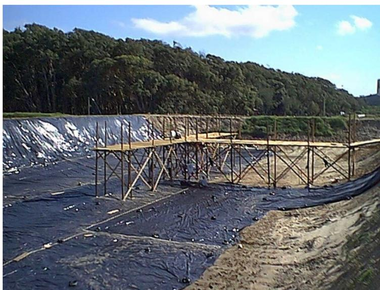
Figura 4. 1 – Implantação das Bacias de Sedimentação em 2001
