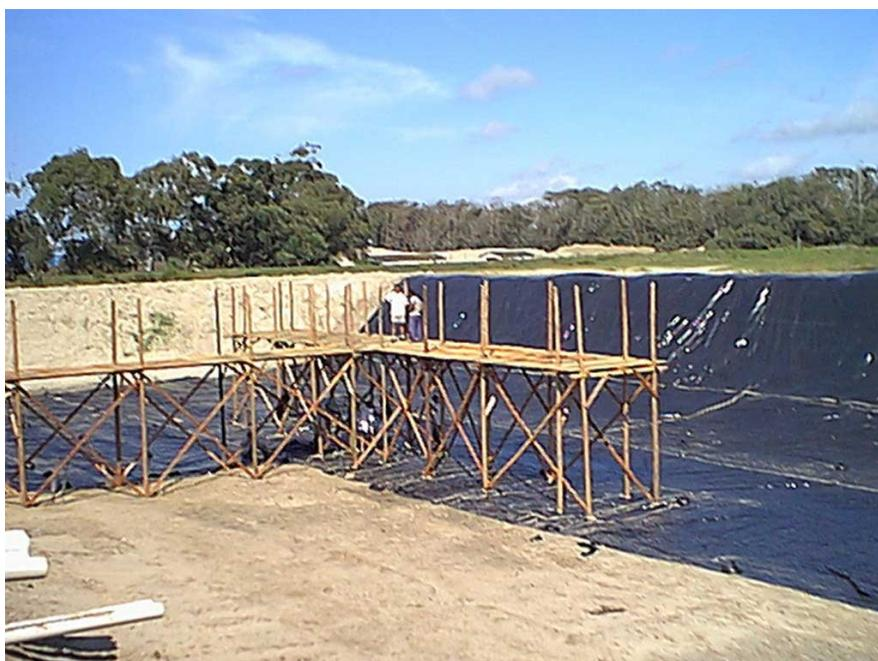
Figura 4. 6 – Impermeabilização parcial do fundo da bacia de decantação 2.
