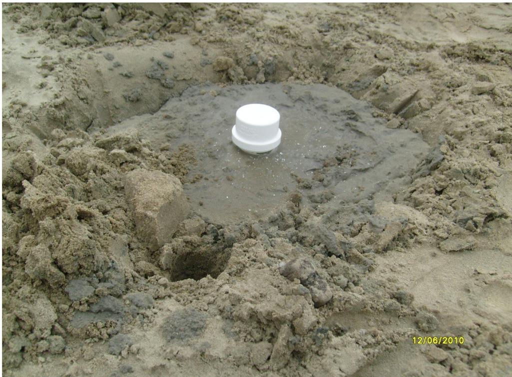
Figura 8 - Poço de monitoramento instalado.
