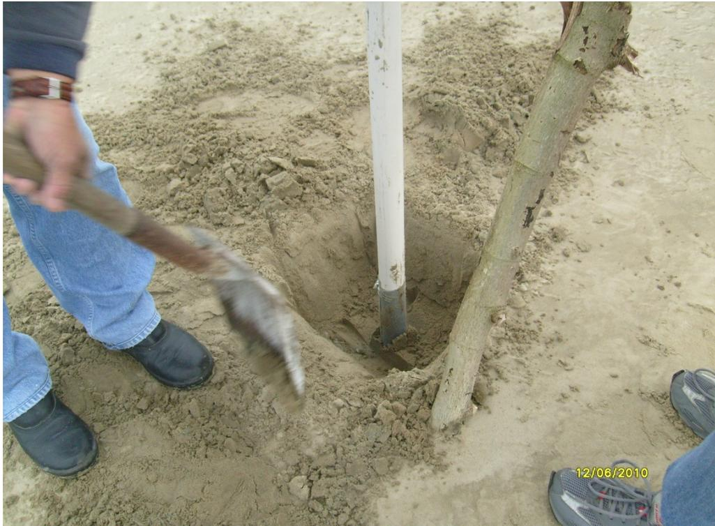
Figura 7 - Poço instalado antes da concretagem.
