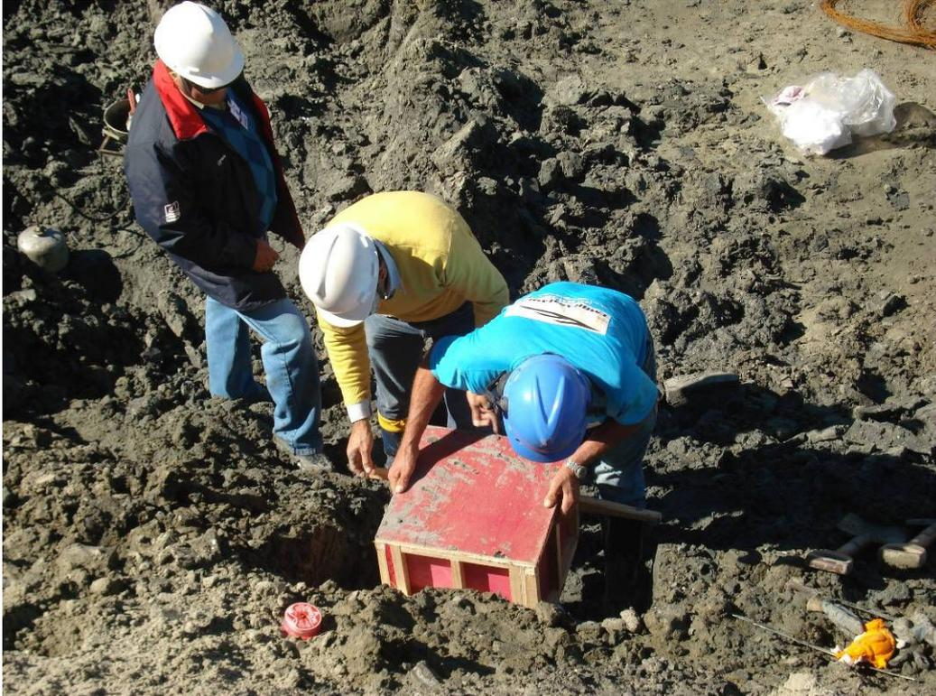
Figura 4.5 - Retirada dos blocos de amostras indeformadas – Dique Seco do Estaleiro Rio Grande
